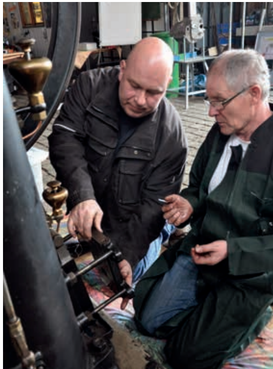
... konnte der Schieber wieder montiert ...
